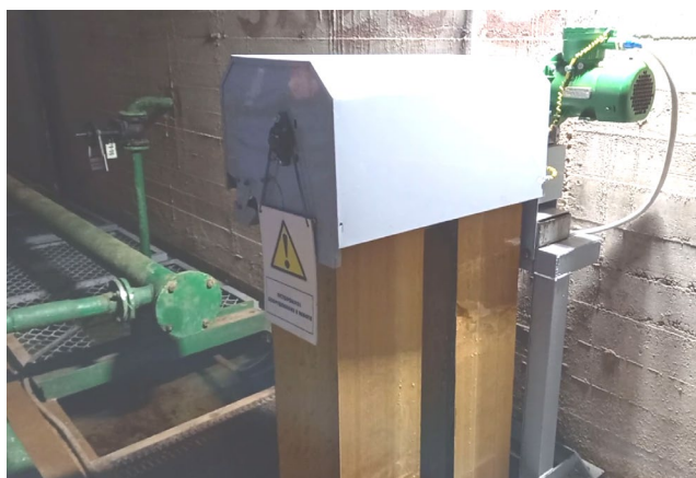
Иллюстрация 3 Ойл-скиммер в лотке дренажной галереи
