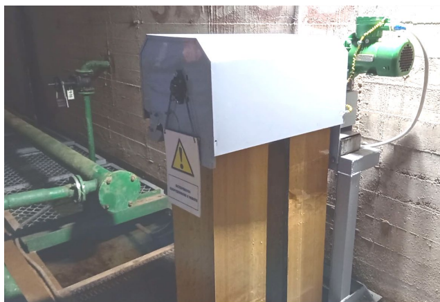
Иллюстрация 3 Ойл-скиммер в лотке дренажной галереи
