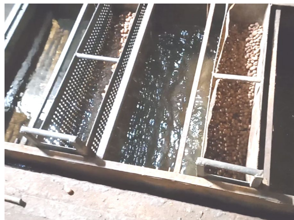
Иллюстрация 4 Фильтрующие кассеты в лотке дренажной галереи
