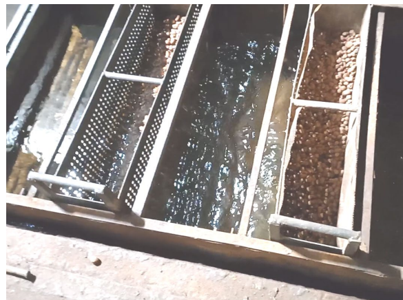
Иллюстрация 4 Фильтрующие кассеты в лотке дренажной галереи
