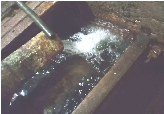
Иллюстрация 1а Начальная часть лотка дренажной галереи
